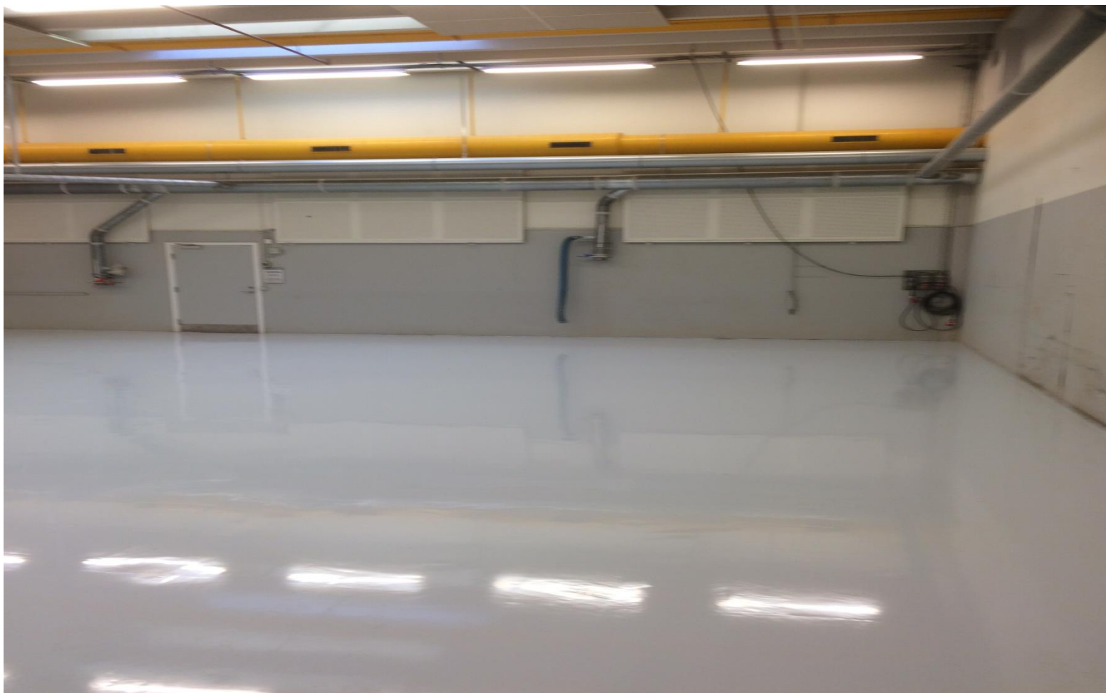
Renovering af gulvoverflade, NEXT, Glostrup
