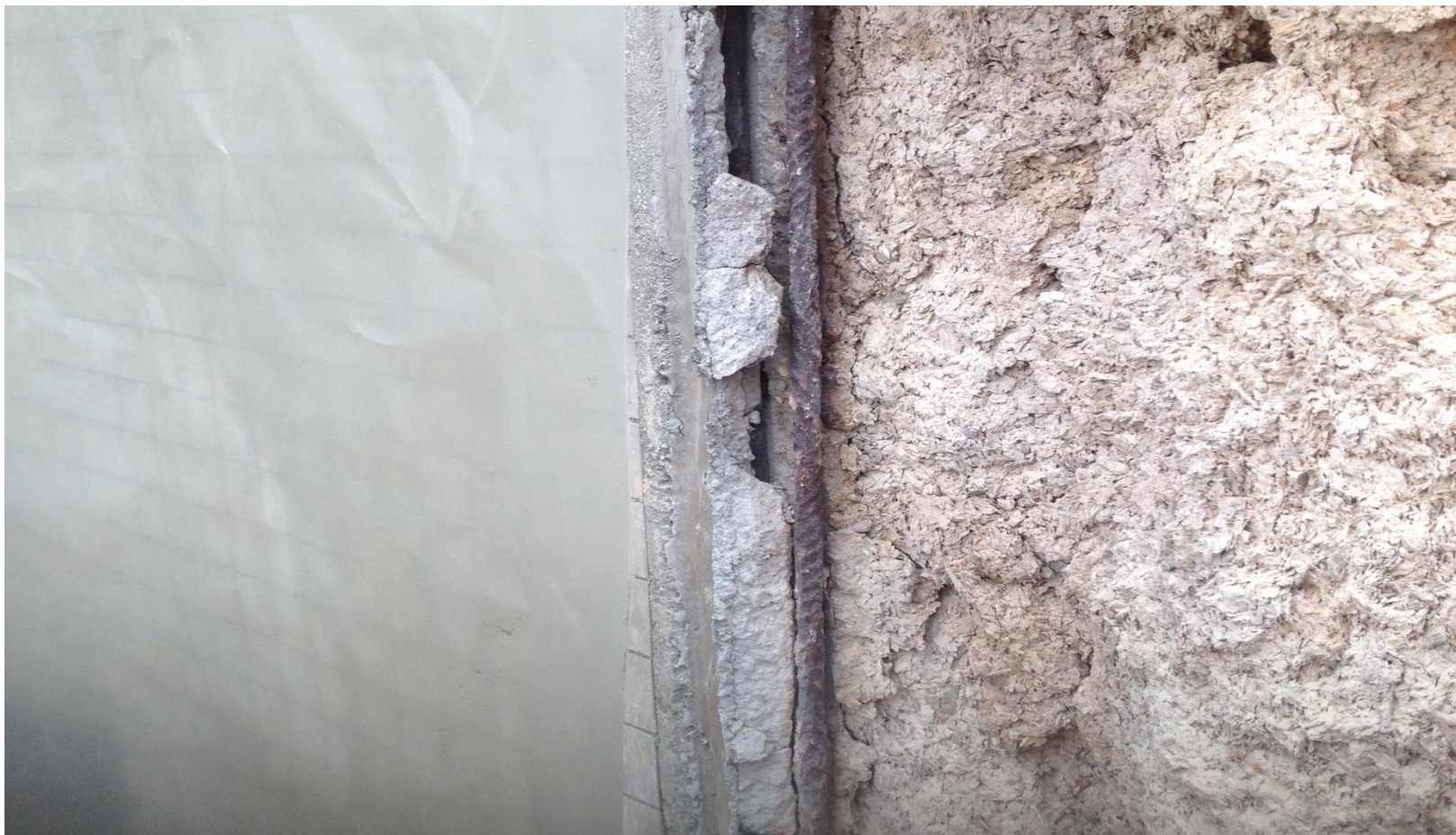
Renovering med sprøjtebeton
