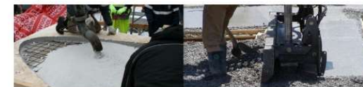
Figur 1. Støbning med hvid SCC beton til venstre. Traditionel sætmålsbeton til højre, hvor vibrering udføres med en bjælkevibrator
