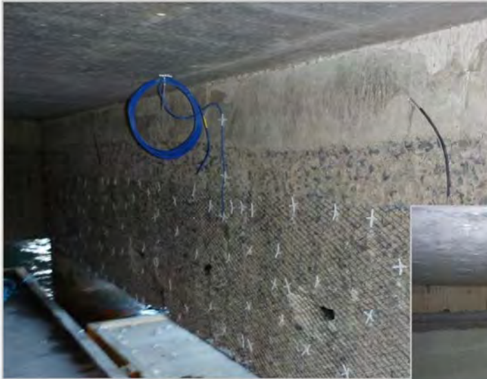
Bjælke med anodenet
