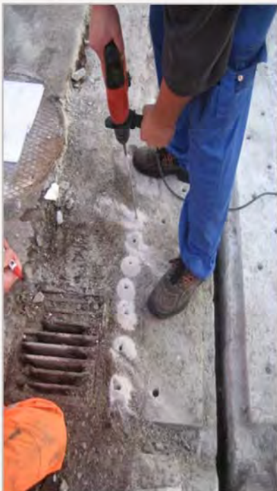
Boring af huller
