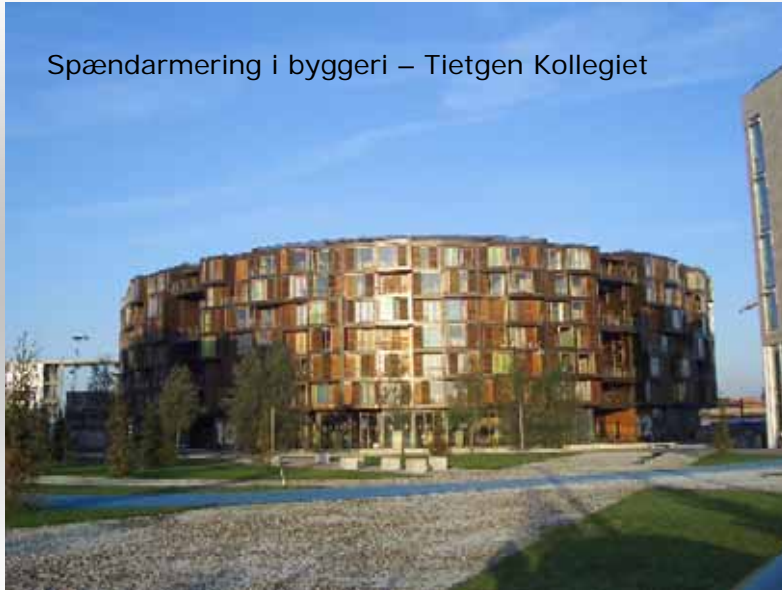
Spændarmering i byggeri – Tietgen Kollegiet
