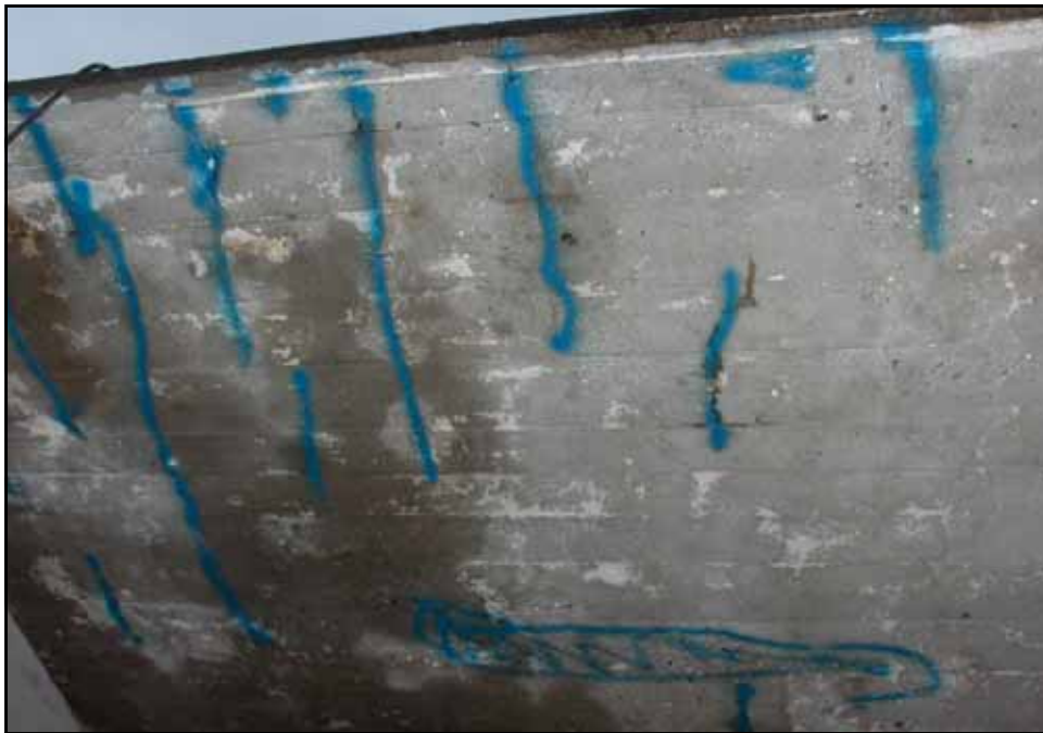
Fritlægning af armeringsjern i forbindelse med beton renovering i kødbyen.
