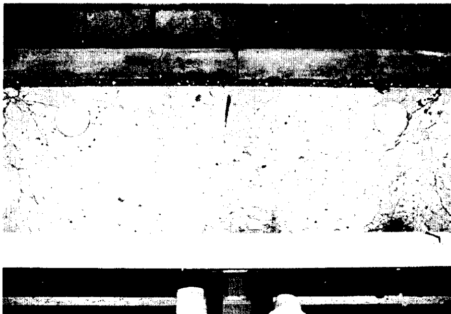
Fig. 2 Revner i fortovsflade af brokantelement, mest udtalt ved hjørner.
