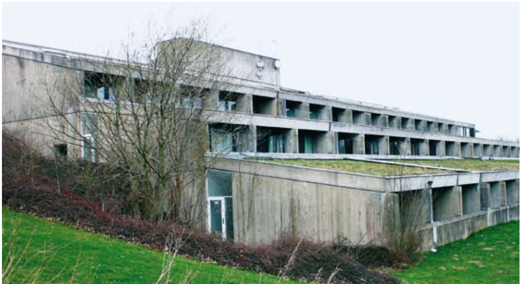
Friis & Moltke har skabt betonbygninger, der patinerer smukt. Her Scanticon i Århus.
