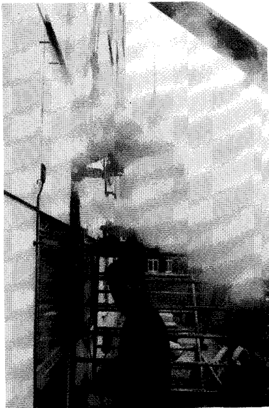
Figur 1. Skæring af fuger. Skæring uden vand giver en voldsom støvudvikling og et højt støjniveau: 106 dB(A) ved udstyret og max. 72 dB(A) i bygningen. Støvudviklingen kan begrænses ved vandsivning eller sug.
