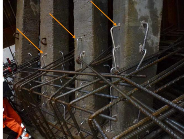
Iboret strittere pr. 200 mm på forside af skråpæle
