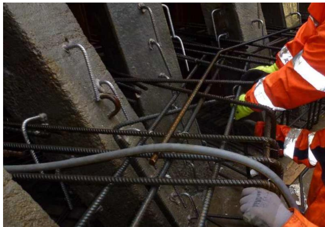
Langsgående armeringsjern pr. 200
