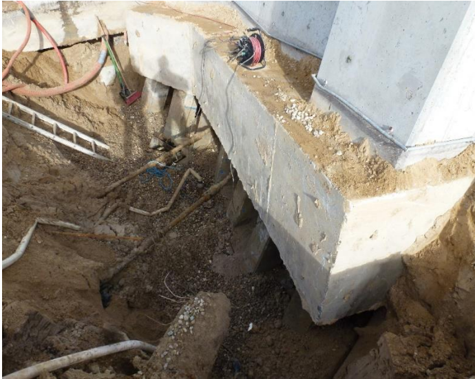
Oversigtsbillede over udgravning.
