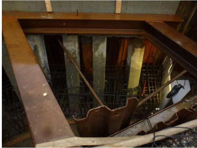
Armeringsarbejde på den nederste del er næsten færdiggjort.
