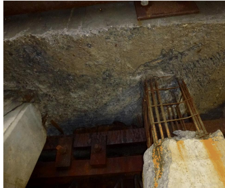
Skråpæl hvor skadet beton er fjernet i den øverste del af pælen.
