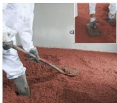
Fyld resten af arealet op, komprimer og afret efter de opbyggede aftrækshøjder.
