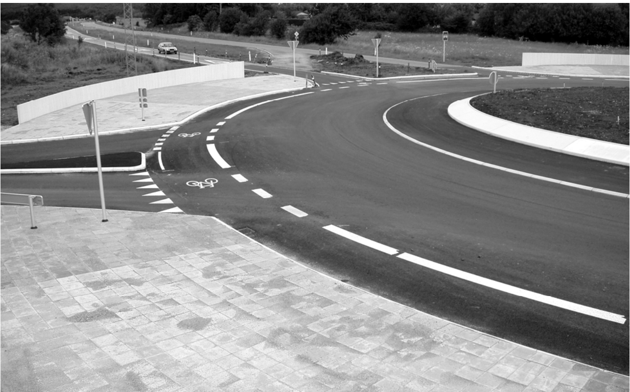
Figur 3: Rundkørslen tæt på færdiggørelse: Vejens forløb er let overskueligt, og kontrasten mellem vejbane og afgrænsende elementer er meget stor i fugtigt vejr. Der ligger stadig sand på de farvede felter efter fugeopbygning mellem fliserne.
