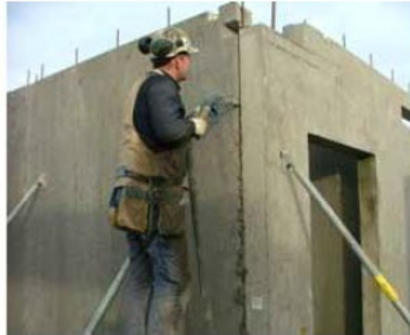
Udstøbning af vægfuge med Putzmeister-teknik. Denne metode kræver særlig uddannet personale for at kunne sikre veludstøbte fuger.
