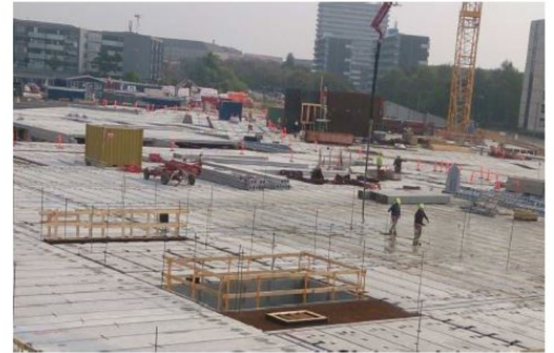
Udstøbning af fuger mellem huldækelementer på byggeplads
