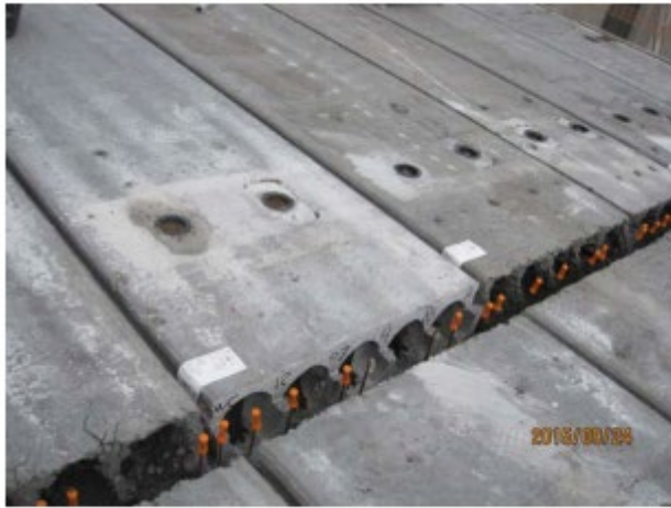
Fuger mellem huldækelementer før ilægning af armering og fugeudstøbning
