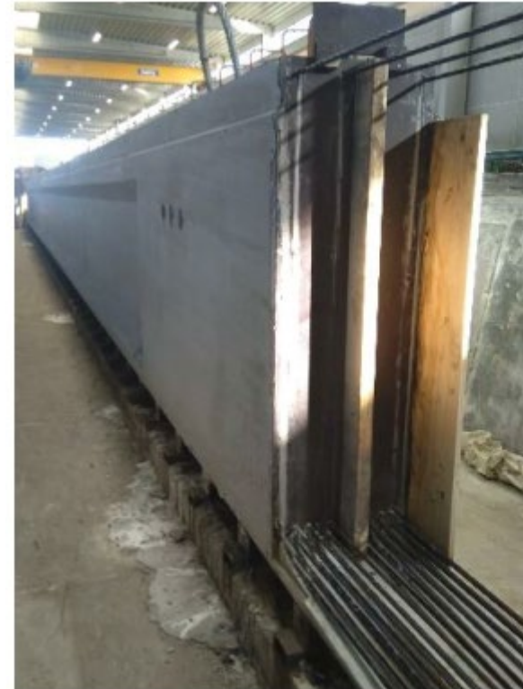
Strengbetonbjælke under afforskalling på spændbord før overskæring af liner
