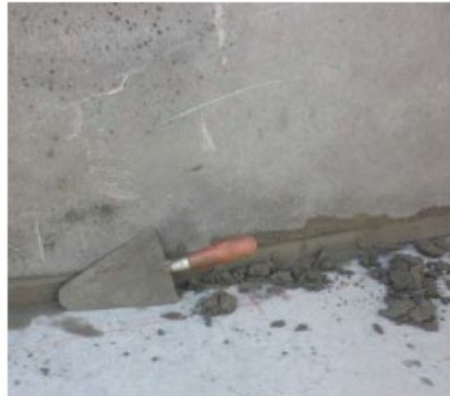
Fuger mellem huldækelementer før ilægning af armering og fugeudstøbning
