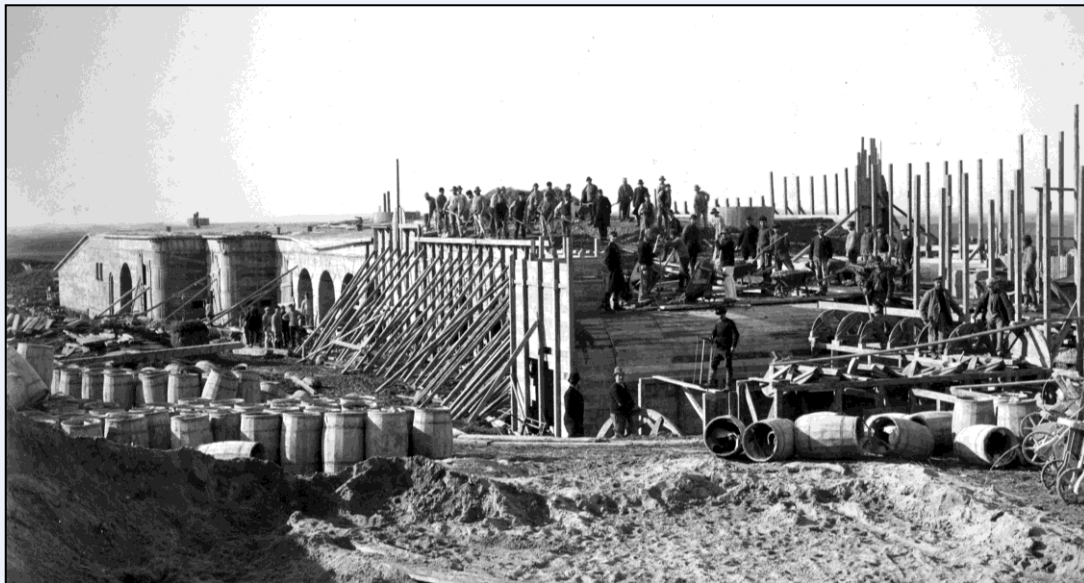
Fortunfortet under opførelse den 24. februar 1892. Kilde: Krigsmuseet.
