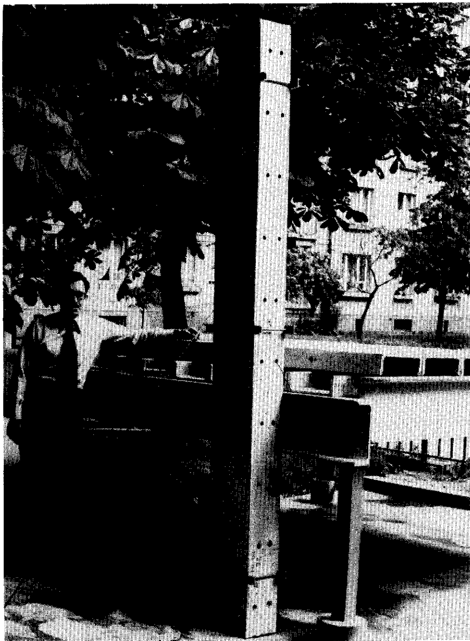
Facade-dæk-og søjleelementer. Ferrocementlaboratoriet Warszawa 1977
