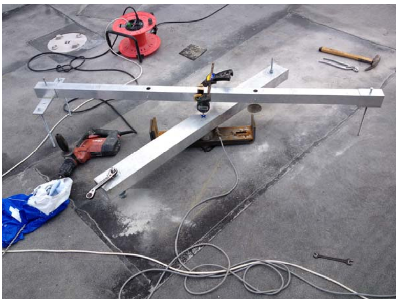
Foto af opstilling. Asfalt membran er skåret væk i punktet.
