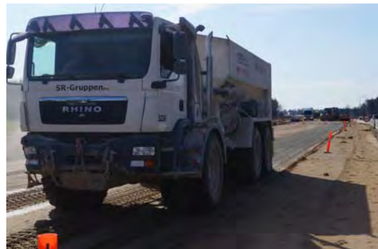
Udlægning af cement.
