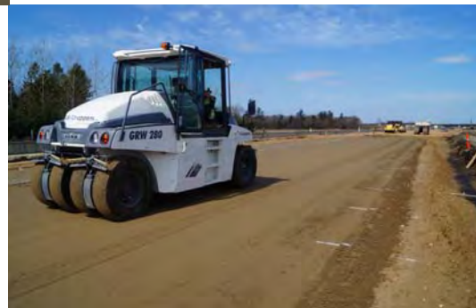
Tromling/komprimering med gummihjulstrømler
