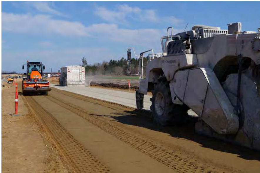
Komprimering med valsetog.
