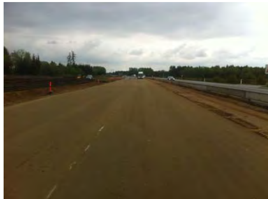
Tromling/komprimering med 20 ton gummihjulstrømler.
