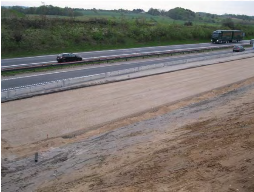
Inden cementstabilisering
