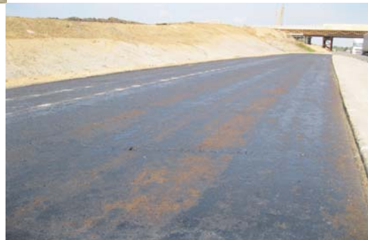
Klar til asfalt.
