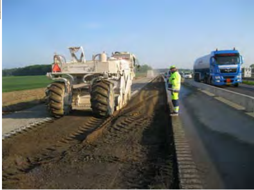
Fræsning af cement og SG.
