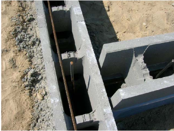
Figur 6. Placering af armering
