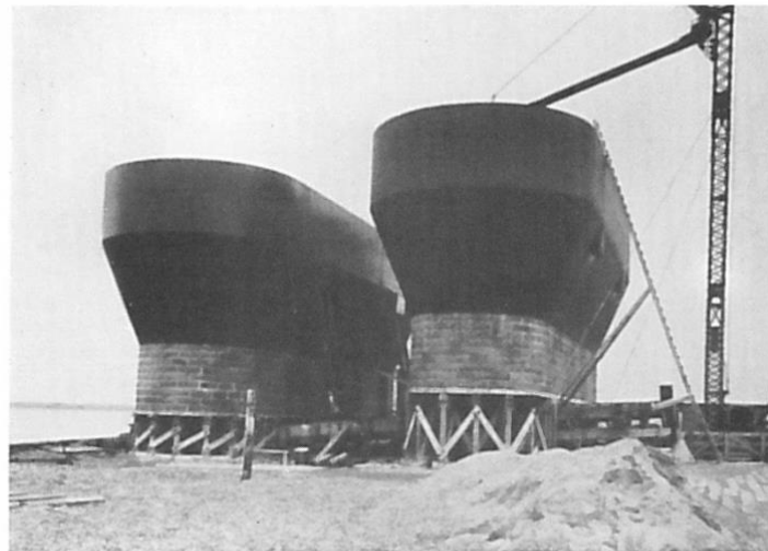
2 Sænkasker paa Beddingen, omtrent færdige til Stabelaflobning. Forneden ses Granitbeklædningen. Til højre Støbemasten
