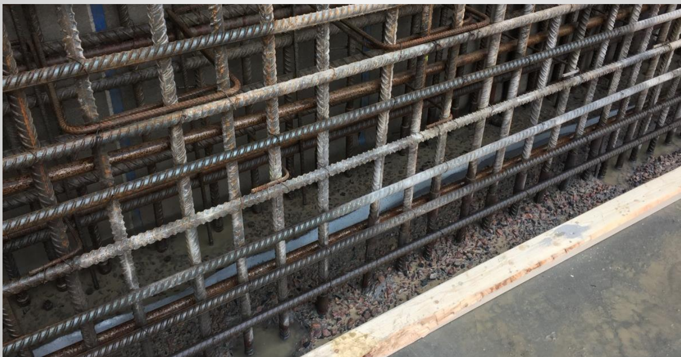
Etablering af vandtætte støbeskel
