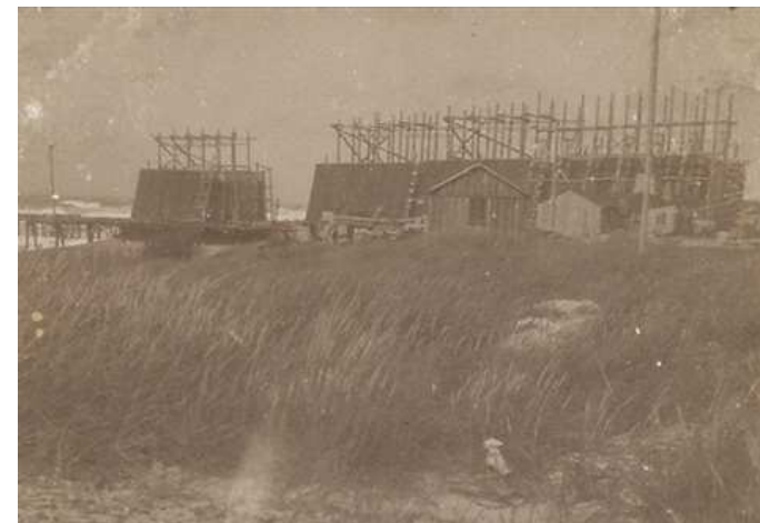
Anlæggelse 1930 – tømmerkistekonstruktioner, som efterfølgende fyldes med ral
