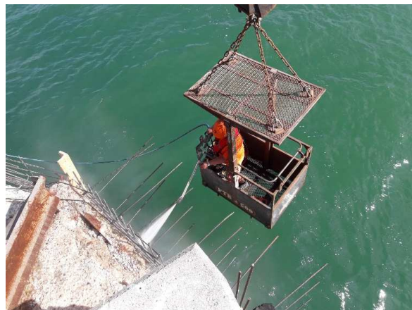
Aftrensning før forskallingsarbejde - 2019
