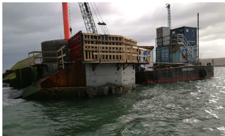
Forskalling til reparation af molehoved - 2019
