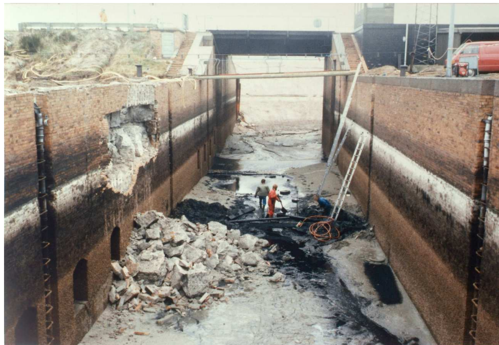
Kammersluse – udvidelse 1987 – eksisterende sluse - tørlagt.
