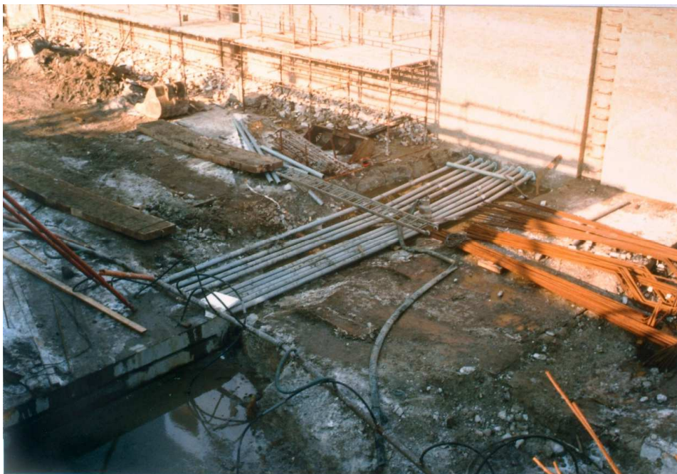
Kammersluse – udvidelse 1987 – anlægsfasen
