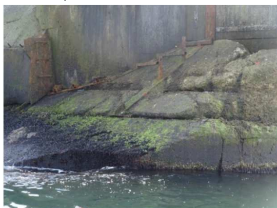
Nedbrydning af beton på molehovedet
