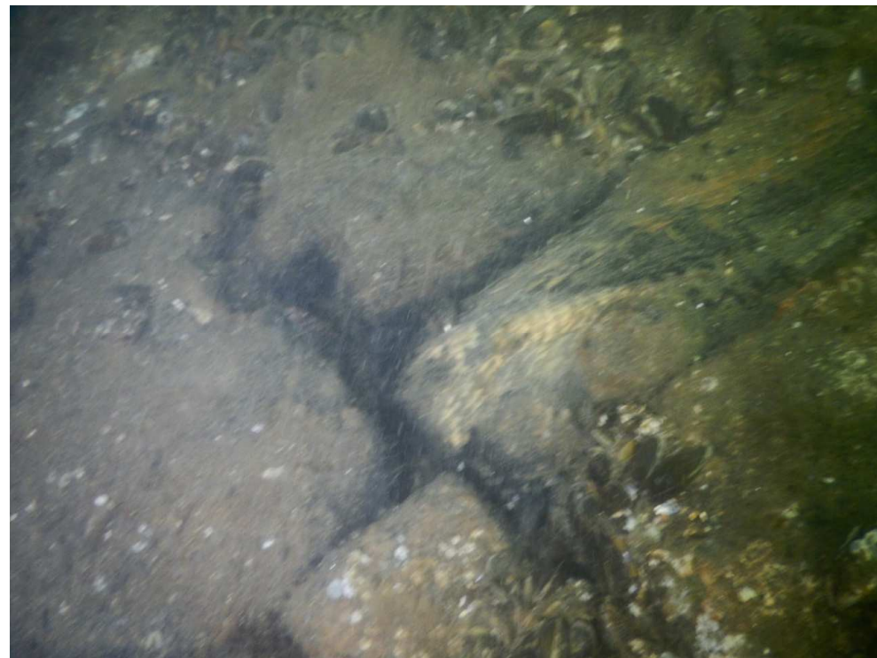
Dykkervideo – Kammerslusen overgang mellem beton og tegl..
