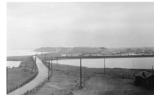
Kammersluse og afvandingsluse i 1931
