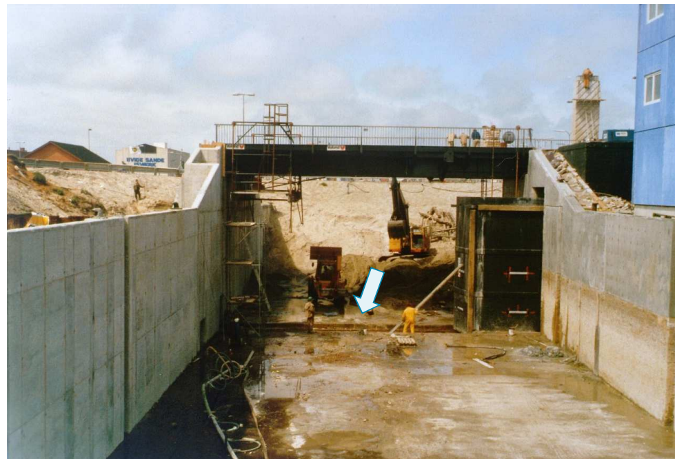
Kammersluse – udvidelse 1987 – færdigbygget – fjernelse af diger pågår.
