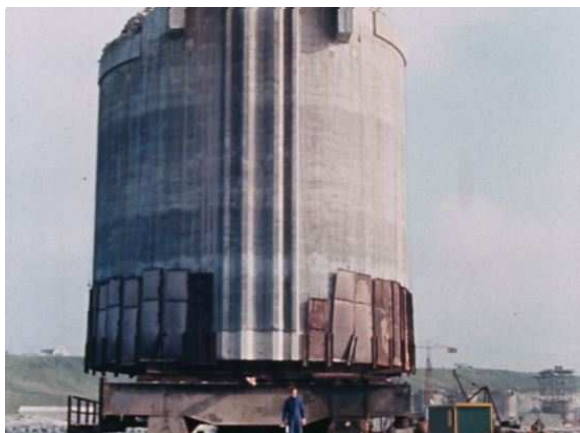
Transport af sænkekasse på skinner til udsætning
